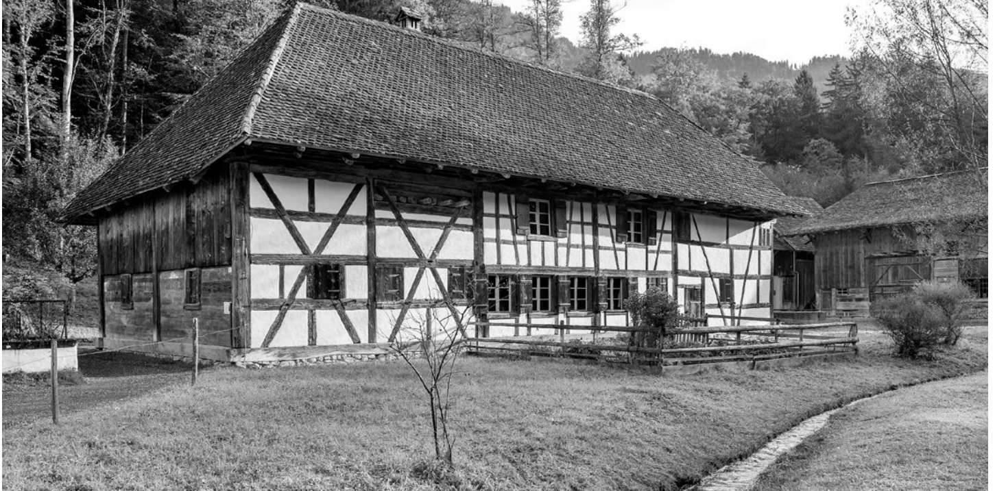
Zwei Bautechniken wurden beim Bauernhaus in Uesslingen vereint: der Ständerbau mit eingelassenen Balken und der Fachwerkbau mit Flechtwerk und Lehm. Foto: Freilichtmuseum Ballenberg
