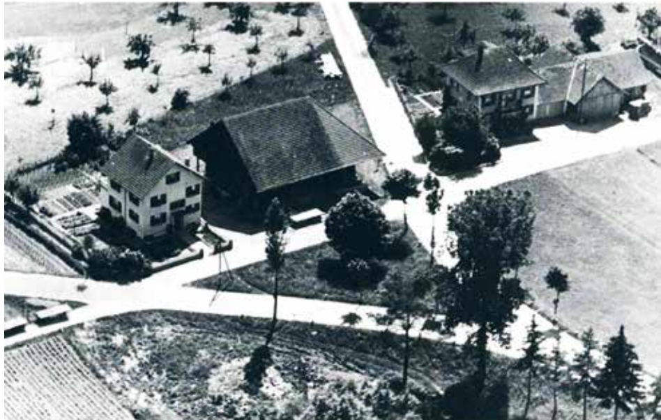
Die Strassen teilen sich Richtung Frauenfeld und Winterthur. Links Alfons Lenz (Zimmerei), heute Garage Grubenmann, und rechts Otto Lenz (Baugeschaft) südlich des Dorfes.
