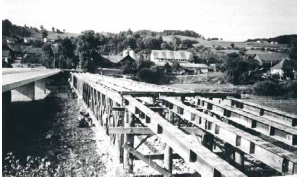
Die Brücke von 1890 hat ausgedient. Sie war dem heutigen Verkehr nicht mehr gewachsen. Daneben entsteht eine neue aus Stahl und Beton.
